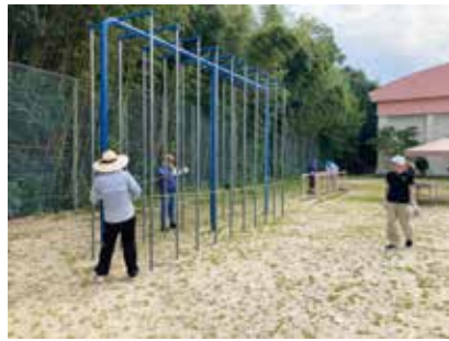
遊具の使用禁止、立ち入り禁止等措施
